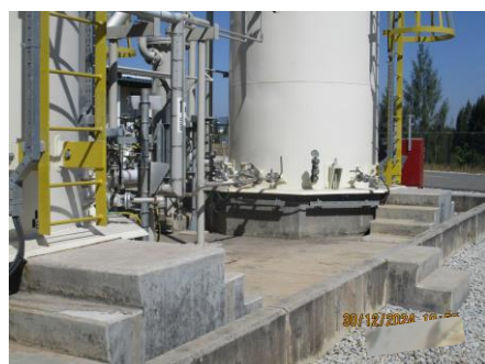
ภาพที่ 2-18 คันกั้นล้อมรอบลานถังเก็บกัก
