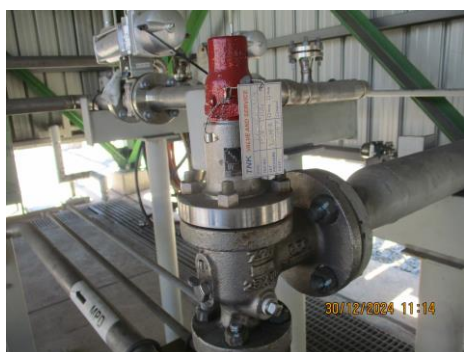
ภาพที่ 2-22 วาล์วฉุกเฉิน (Automatic Isolation Valve)
